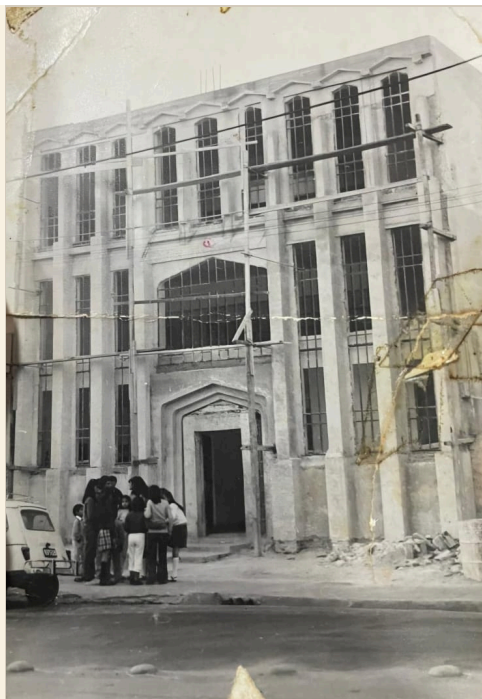
Construyendo nuestra Iglesia "Centro Cristiano" calle Boulevard San Juan N° 1296, ciudad de Córdoba
